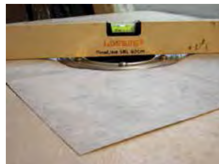
6. Hidroizolacijska garnitura je ispod nivoa košuljice
