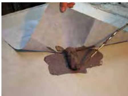
7. Hidroizolacijski premaz nanijeti ispod folije
