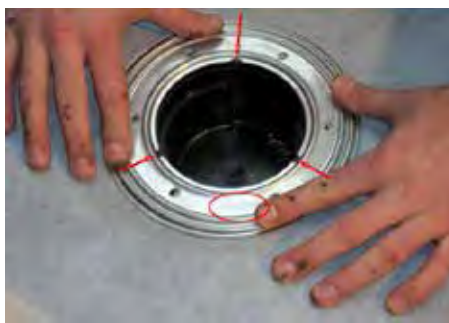
4. Prvo postaviti foliju te preko folije postaviti pribudnicu. Prilagoditi INOX-prsten prema slivniku i voditi računa o gornjoj strani prstena na kojoj piše „OBEN“
