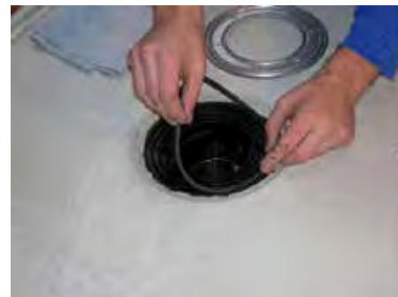
3. Ukloniti zaštitni poklopac, te gumicu (dichtung) postaviti u predviđeno udubljenje
