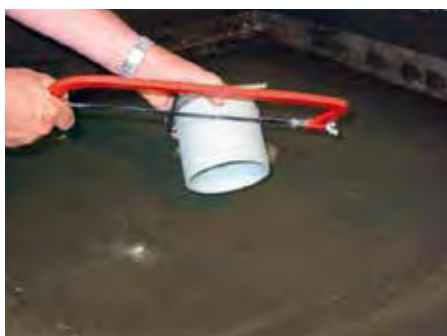
11. Skratiti nastavak na visinu pločica
