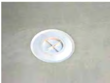
2. Ostaviti da se cementna košuljica osuši
