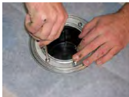
5. INOX-prsten pričvrstiti pomoću vijaka na pribudnicu slivnika
